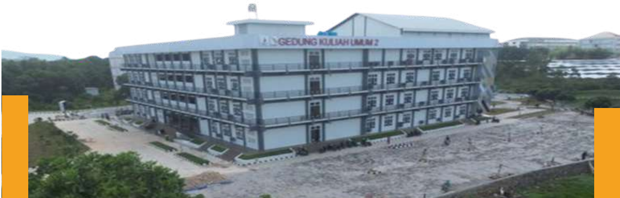
1. Institut Teknologi Sumatera (Gedung Kuliah Umum 2)
